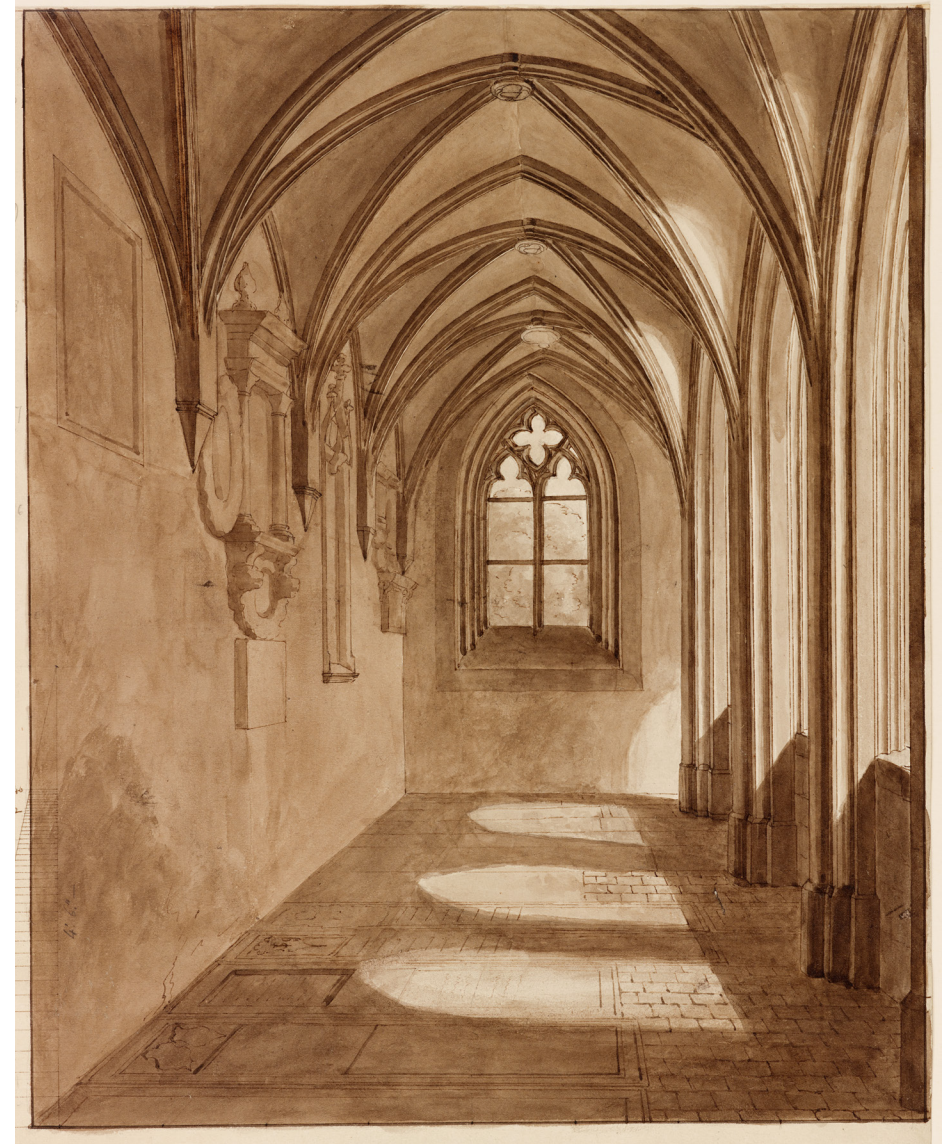
Abb. 5: Nordwand des kleinen Kreuzganges um die Mitte des 19. Jhs.
